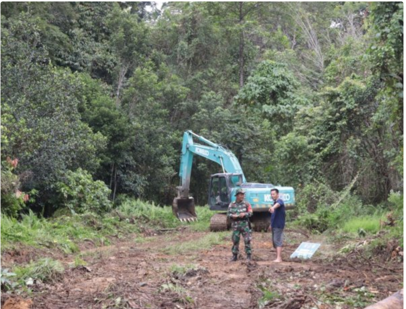
Wujudkan Aspirasi Warga, TMMD Wiltas 118 Kodim 0910/ Malinau Bangun Jalan Baru
