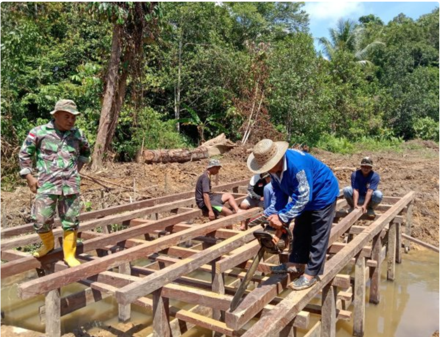
Kepala Desa Kaliamok Terjun Langsung Bersama Warga Bantu Satgas TMMMD ke- 118 Membuat Jembatan
